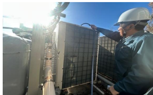
台風後の機器洗浄の様子
