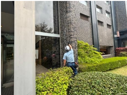
外壁タイルの浮き、剥がれの点検風景
